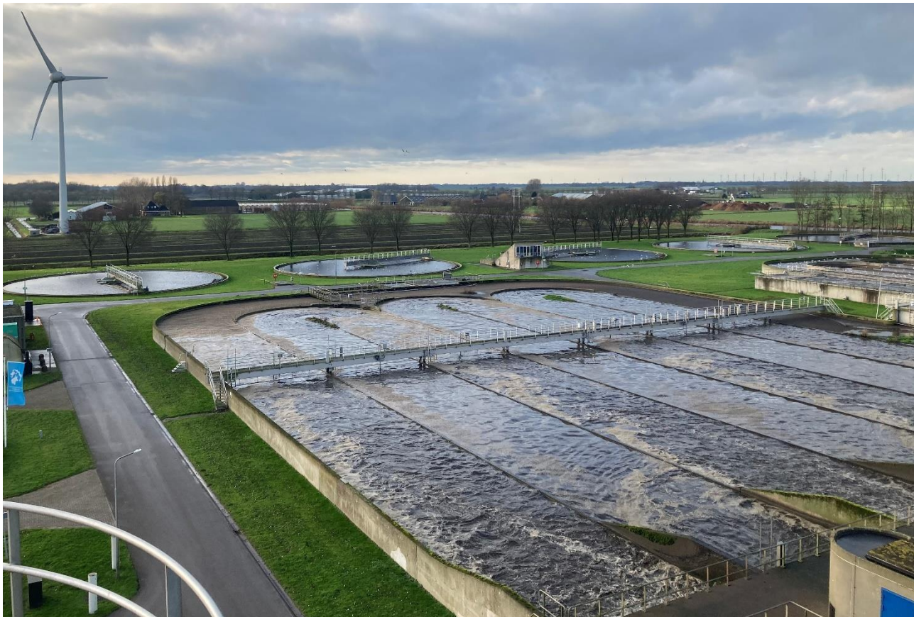
Figuur 5: De rioolwaterzuiveringsinstallatie van HHNK in Wervershoof (bron: HHNK, Philippe van de Loo)
